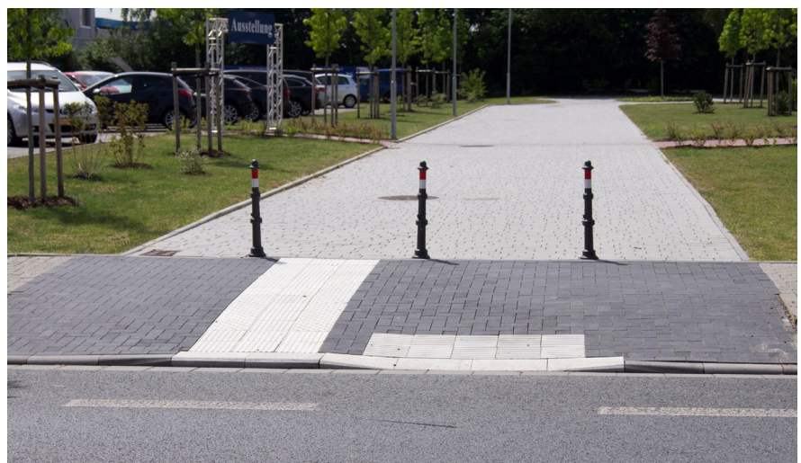
Abb. 61 Abgesenkte Bordsteinkanten i. V. m. einem Leitsystem.
