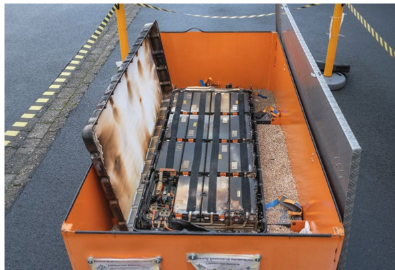
Abbildung 18: Beschädigte HV-Batterie nach Brand
