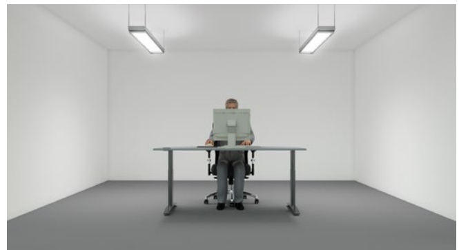
Abb. 19 Beispiel für Direkt-/Indirektbeleuchtung
