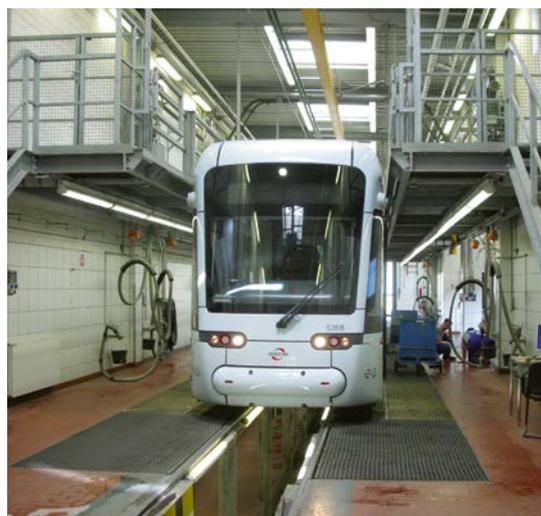
Für die Arbeitsgruben sind in sinnvollen Abständen geeignete Übergänge vorzusehen, abhängig von der Fahrzeuglänge. Hierzu werden im Allgemeinen Gitterroste verwendet, die, wenn von dort aus an den Fahrzeugen gearbeitet werden soll, mindestens 1,5 Meter breit sein müssen. Alternativ kann ein schmalerer Rost mit mindestens 1 Meter Breite mit einem Geländer ausgerüstet sein, der aber gegen Umkippen gesichert sein muss.
