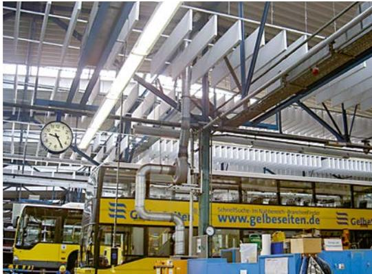
Abbildung 13: Lärmreduzierung durch technische Maßnahmen
