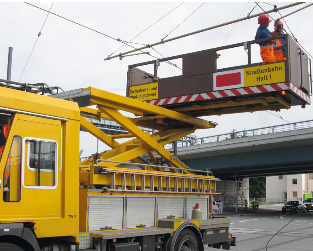
Abbildung 9: Beim Schwenken der Arbeitsbühne ins Nachbargleis sind gegebenenfalls Sicherheitsmaßnahmen bis hin zur Gleissperrung erforderlich, als wäre das Gleis selbst durch das Arbeitsfahrzeug besetzt.
