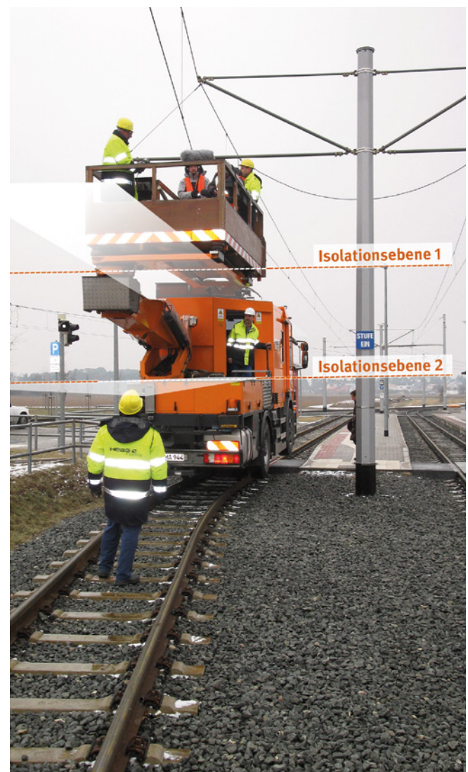
Abbildung 3: Für Arbeiten auf Fahrleitungspotenzial muss jede Hubarbeitsbühne doppelt isoliert sein.
