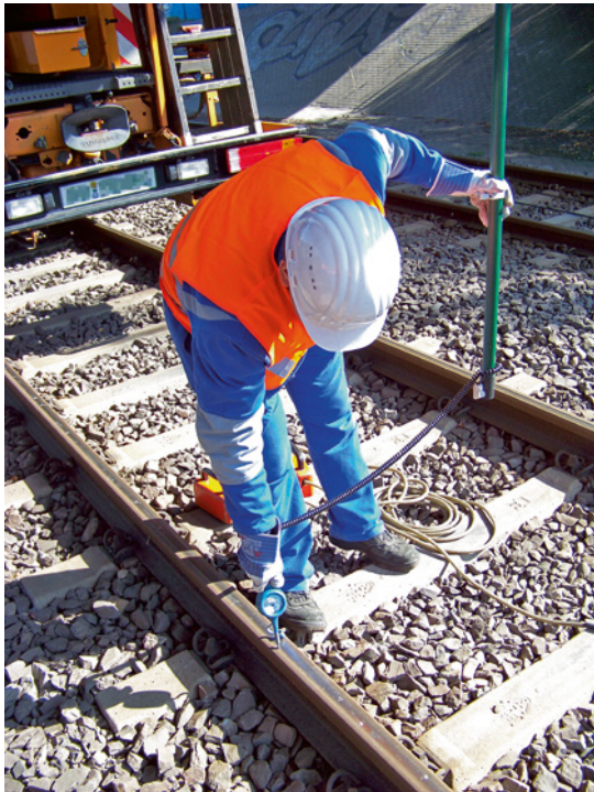
Abbildung 4: Mit dem Messen der Fahrdrachtspannung wird die Spannungsfreiheit festgestellt. Diese Sicherheitsmaßnahme ist nach dem Abschalten die Dritte der fünf Sicherheitsregeln.
