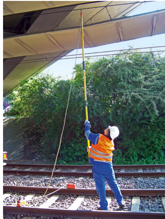
Abbildung 5: Bei Straßenbahnen erfolgt das Erden (vierte Sicherheitsregel) in der Regel mittels Gleismagneten.
