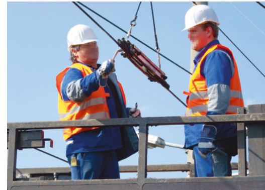
Abbildung 10: Auf der Plattform der Hubarbeitsbühne wird die erforderliche persönliche Schutzausrüstung benutzt.
