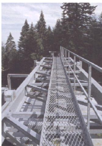
Umlenkstationen müssen mit Laufsteg und Handlauf ausgerüstet sein, da eine Reihe von Instandhaltungsarbeiten von oben durchgeführt werden. Auch ein nicht eingezogener Schleppbügel, der sich zwischen Förderseil und Scheibe verhakt hat, kann meist nur von hieraus wieder gelöst werden.
