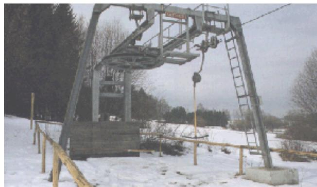
Eine vorbildliche Umlenkstation ist mit Steigleiter, Überstieghilfe, Laufsteg mit Handlauf sowie einem Arbeitspodest zwischen den Ein- und Auslaufrollen ausgerüstet.
