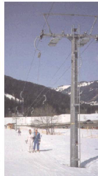
Arbeitspodeste auf Stützen sind über Steigleitern sicher zu erreichen. Für Arbeiten an Rollenbatterien erleichtern fest angebrachte Abhebeeinrichtungen das Abheben des Förderseiles.
