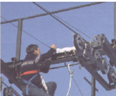
Instandhaltungsarbeiten an Seilrollen, Stützenschaltern und Steuerleitungen lassen sich von einem ausreichend bemessenen und gut erreichbaren Arbeitspodest schnell und sicher durchführen. Zum Schutz gegen Absturz ist ein Auffanggurt zu benutzen. Das Sicherheitsseil ist an geeigneter Stelle anzuschlagen.
