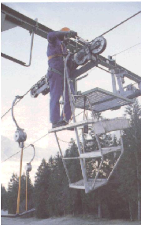
Für Instandsetzungsarbeiten an Schlepliften dürfen Arbeitsgehänge nur eingesetzt werden, wenn der Hersteller bestätigt hat, dass die Anlage entsprechend gebaut ist. Werden Arbeiten von der erhöhten Standfläche des Arbeitsgehänges aus durchgeführt, muss persönliche Schutzausrüstung gegen Absturz benutzt werden.
