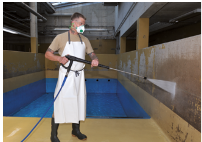
Hochdruckreinigung mit Persönlicher Schutzausrüstung: Schutzbrille, Gehörschutz, Atemschutz, Gummistiefel und Gummischürze
