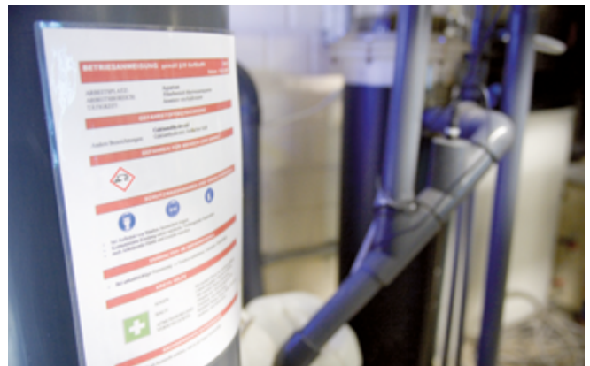
Die Inhalte der Sicherheitsdatenblätter dienen unter anderem zur Erstellung der Betriebsanweisungen für die Beschäftigten.
