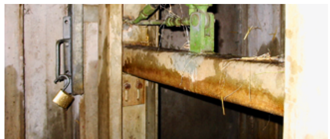
Bei Schiebern müssen Hydraulikschläuche, Bolzen und Gestänge regelmäßig überprüft werden.
