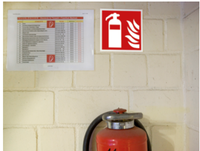
Kennzeichnung der Brandschutzeinrichtung
