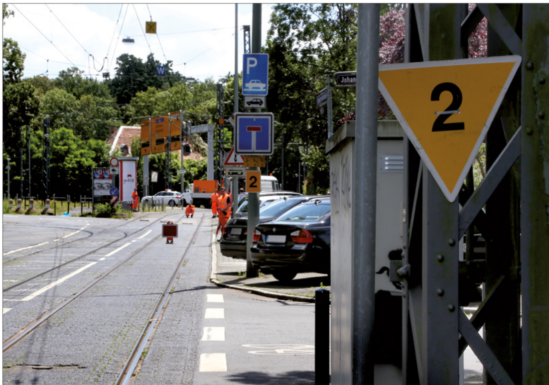
Abbildung 18: Die Langsamfahrstelle ist nie alleinwirkende Sicherungsmaßnahme. In diesem Beispiel ist das Sh 2-Signal mit einer Langsamfahrstelle kombiniert.
