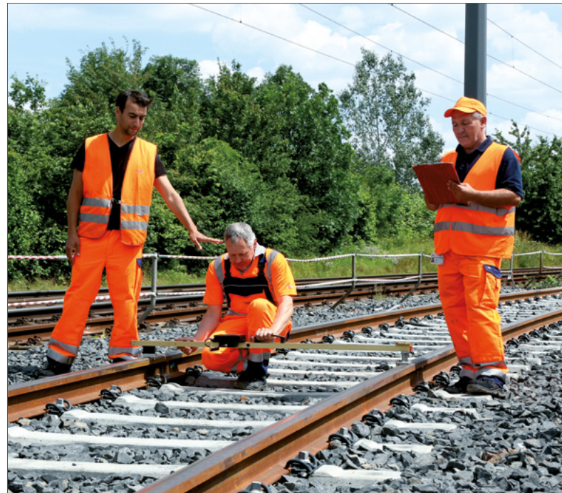
Abbildung 20: Bei der Kleingruppe bis zu 3 Beschäftigten darf sich die Sichernde Person nicht an den auszuführenden Arbeiten beteiligen.
