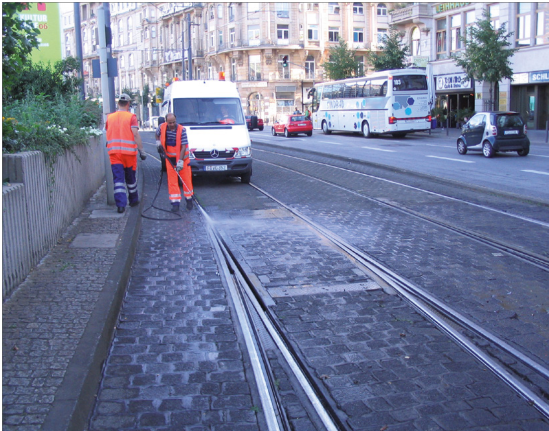
Abbildung 21: Die Weichenreinigungsarbeiten werden in diesem Beispiel im Schutz des stehenden Fahrzeugs durchgeführt.
