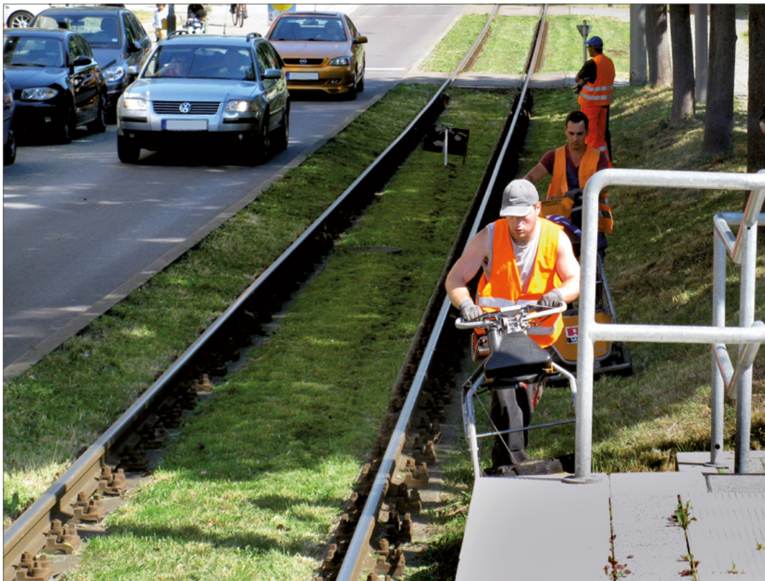
Abbildung 5: Vegetationspflegearbeiten sind in der Regel Arbeiten mit einem schnellen Arbeitsfortschritt. In diesem Beispiel wird ein SH 2-Signal zur Gleissperrung eingesetzt, das von einem Posten nachgeführt wird.
