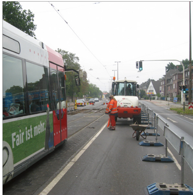
Abbildung 7: Eine Straßenbahn passiert die Arbeitsstelle. Daher ist für die Arbeitsstelle ein Sicherheitsraum einzuplanen, in den sich die Beschäftigten der Arbeitsstelle begeben, um die Vorbeifahrt der Straßenbahn abzuwarten. Gleichzeitig wird dieser Bereich zum Abstellen von Fahrzeugen und zur Lagerung von Material genutzt.
