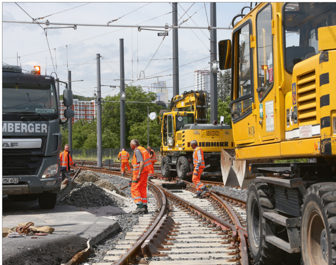
Abbildung 22: Den Beschäftigten der Gleisbaustelle sind eindeutige Verhaltensmaßnahmen im Gleisbereich vorzugeben.
