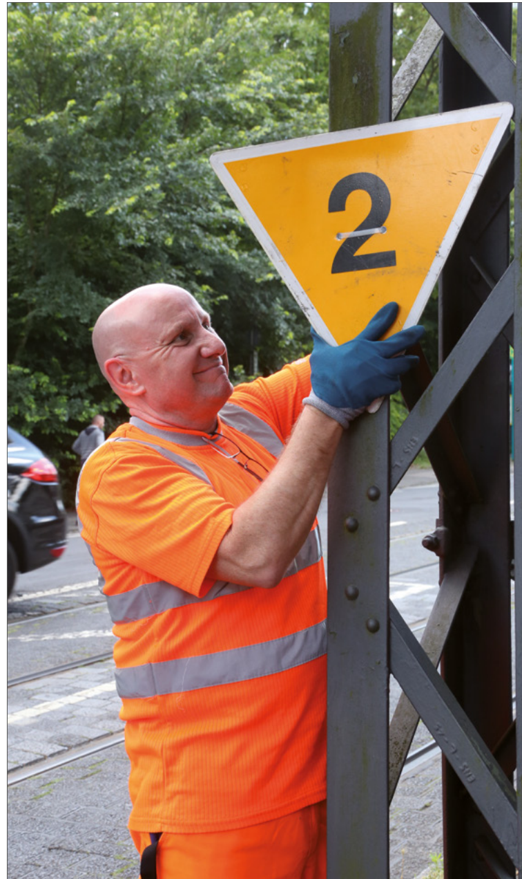
Abbildung 1: Das Einrichten von Langsamfahrstellen ist eine Maßnahme, die zu einem Sicherheitsgewinn für die Beschäftigten in der Baustelle führt.
