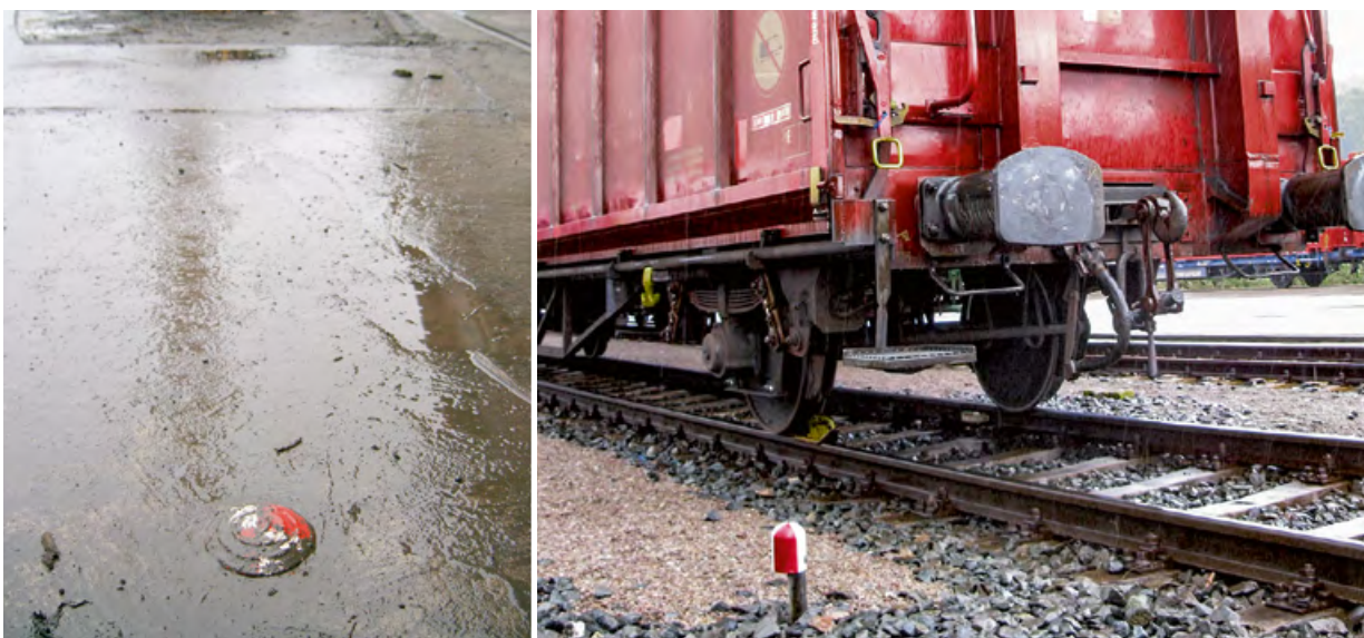
Abbildung 16: Grennzeichen kommen in verschiedenen Bauformen im geschotterten Gleis beziehungsweise in ausgeplatteten Bereichen zum Einsatz.
