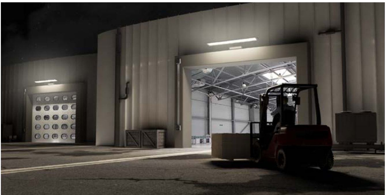
Abb. 31 Gute Beleuchtung im Bereich von Halleneinfahrten vermeidet Unfallgefahren
