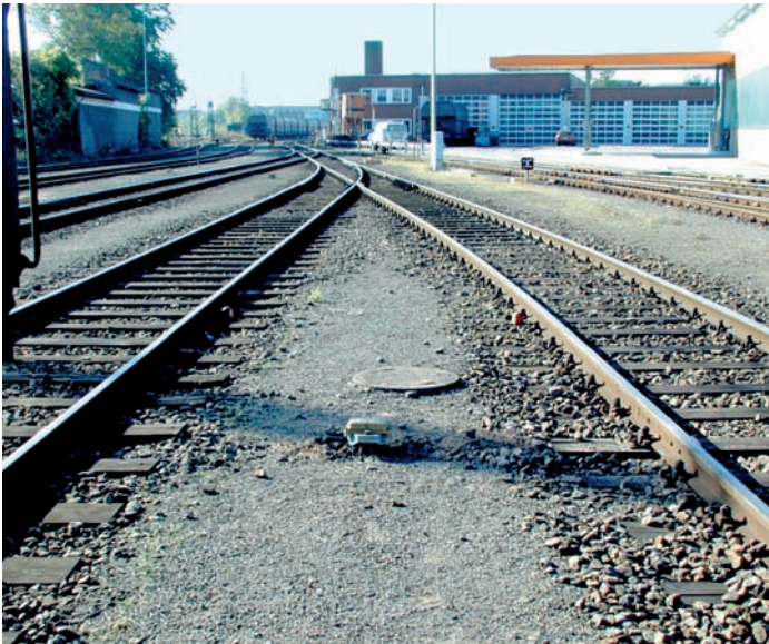
Abbildung 11: Grennzeichen müssen dort gesetzt werden, wo der Sicherheitsabstand zwischen den Fahrzeugen auf den besetzten Gleisen noch vorhanden ist.
