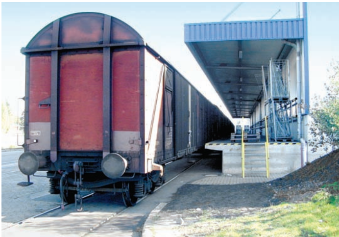
Abbildung 10: Laderampen müssen so errichtet werden, dass Personen im Gefahrfall darunter Schutz finden können, wenn auf der gegenüberliegenden Seite der Rampe neben dem Gleis der Sicherheitsraum nicht vorhanden ist. Die Kanten sind als Gefahrstellen zu kennzeichnen.
