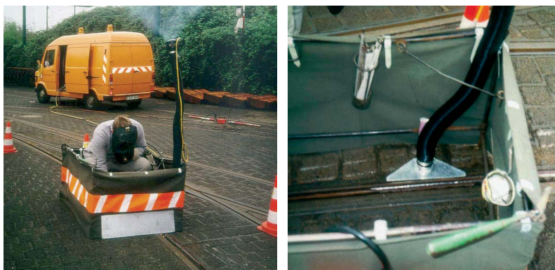
Mobile Schweißrauchabsaugung im Blendschutz integriert mit Schlitzdüse zur Erfassung der Schweißrauche.
