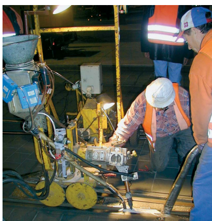
Die Arbeitssituation des Schweißers im Blendschutzkasten zeigt, dass er durch die Schweißposition im Gleis ohne wirksame Absaugung einer starken Belastung durch Schweißrauche ausgesetzt ist. Anstelle einer Absaugung hat sich beim Auftragsschweißen der Fahrkanten auch das raucharmer UP-Schweißverfahren bewährt.
