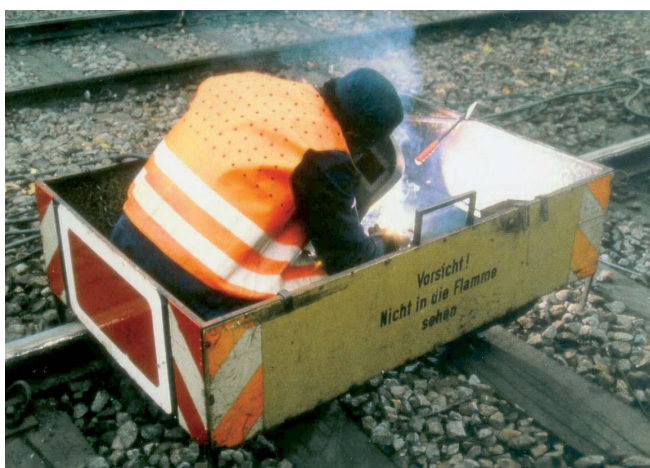
Die Arbeitssituation des Schweißers im Blendschutzkasten zeigt, dass er durch die Schweißposition im Gleis ohne wirksame Absaugung einer starken Belastung durch Schweißrauche ausgesetzt ist. Anstelle einer Absaugung hat sich beim Auftragsschweißen der Fahrkanten auch das raucharmer UP-Schweißverfahren bewährt.
